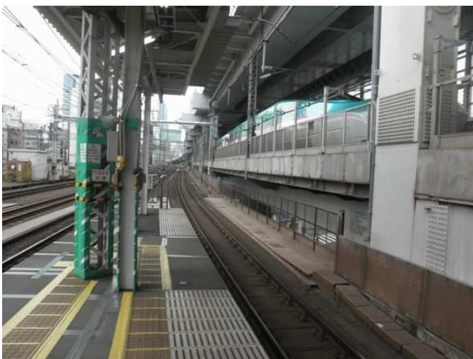
新幹線の上に陸橋がかかっている神田駅（北澤三明）
