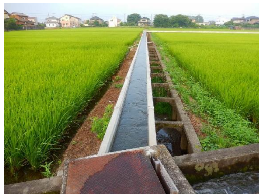
整備された灌漑水路
